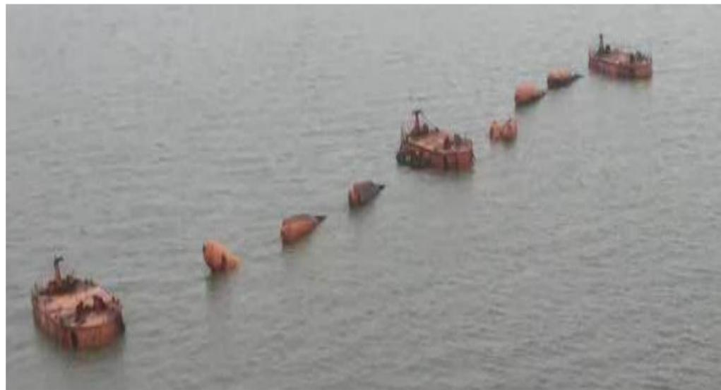
图 5.2 钢缆断落失衡自适应浮筒相互撞击破裂进水沉没、下沉状态
