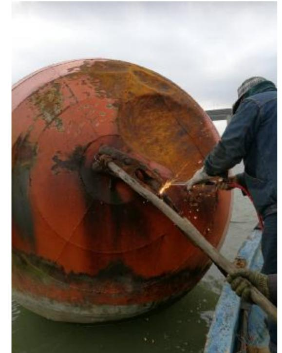
图 5.7 自适应浮筒损坏后修复
