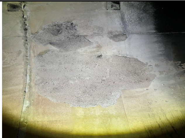
图 3-10 BK2945+963 衬砌 右边墙 H=2m 剥落掉块 S= (2×3) m², Dmax=50mm
