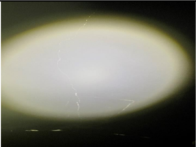
图 3-4 BK2945+975 衬砌 拱顶偏左 2m 斜缝 L=3m,W=0.32mm
