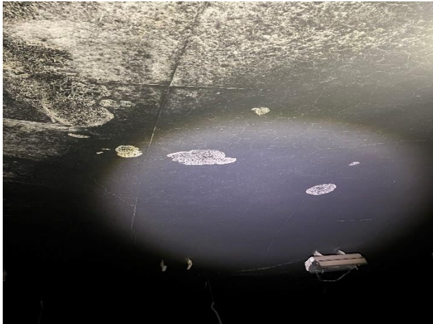
图 3-9 BK2945+958-959 衬砌 拱顶 剥落掉块 5 处 S= (0.01~0.2) m², Dmax=15mm
