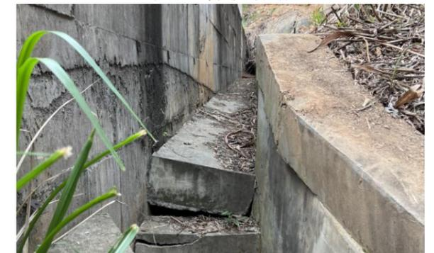
图 5 洞门墙顶水沟破坏
