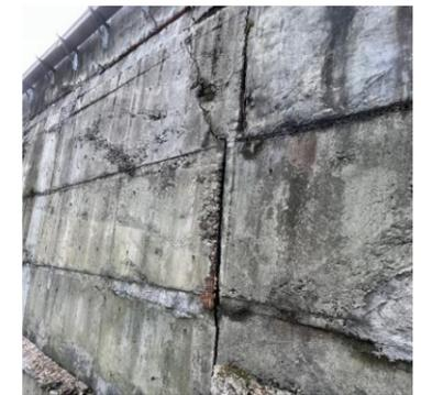
图 8 挡墙开裂
