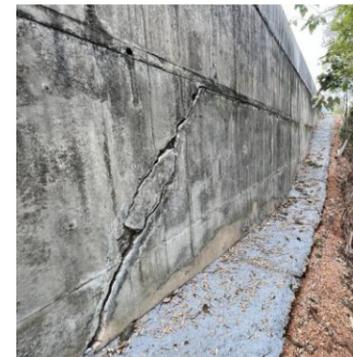
图 2 挡墙开裂
