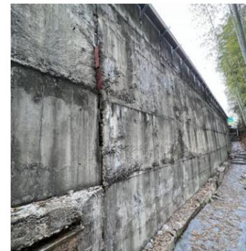
图 7 挡墙开裂
