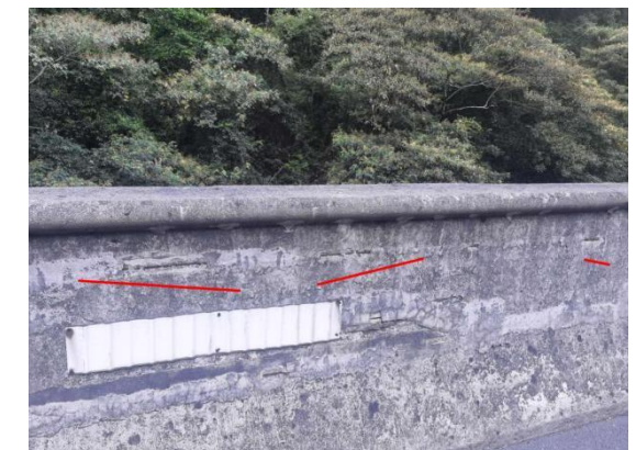
图 3-32: 建安关高架桥(上行) HL-R-1 栏杆、
