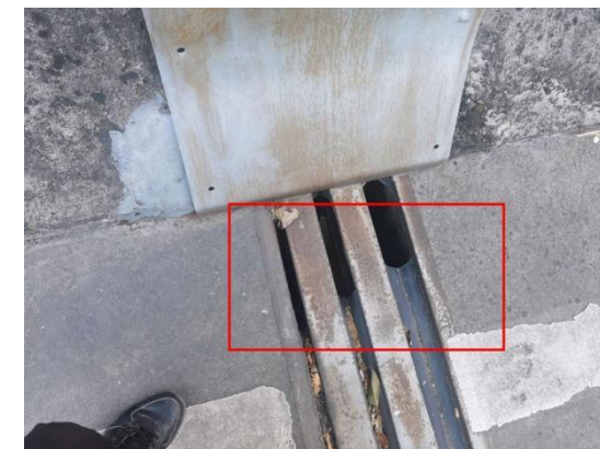
图 3-31: 建安 2#高架桥(上行) R-1f 伸缩缝:
