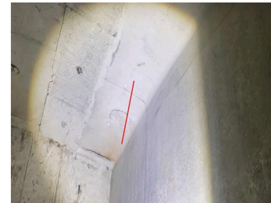
图 3-1：建安关高架桥（上行）23-3T 梁：距 22 号墩 2m 处，右翼缘板纵向裂缝；数量：1 条，长度：1.2m，宽度：0.12mm。
