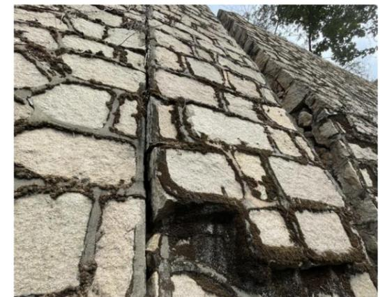
图 3 第一阶挡墙鼓胀开裂
