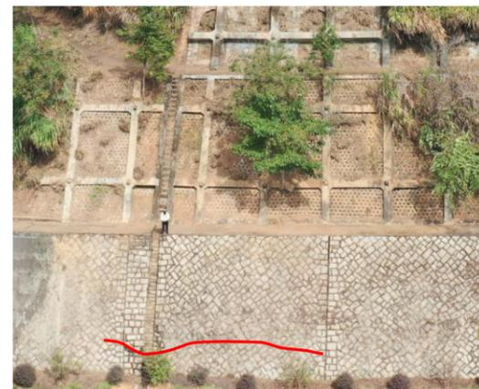
图 2 第一阶挡鼓胀开裂
